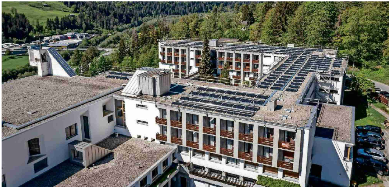
Neu wird auf dem Dach des Ilanzer Klosters Solarstrom produziert.
