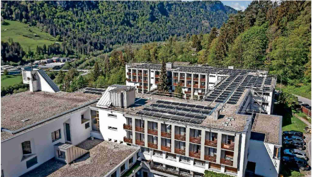
Neu wird auf dem Dach des Ilanzer Klosters Solarstrom produziert.
