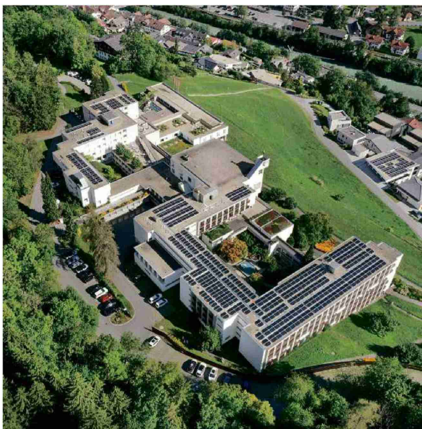
Moderne Energieerzeugung: Auf dem Dach des Klosters Illanz wird auf 1000 Quadratmetern Strom produziert.
